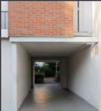
Passage courant sous un immeuble © LMDP, 2015
