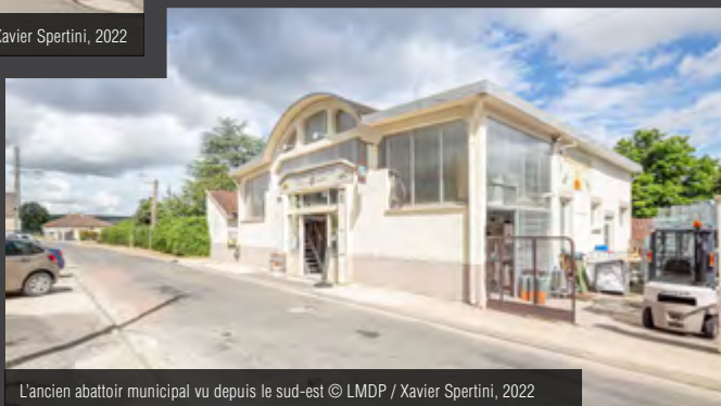
L'ancien abattoir municipal vu depuis le sud-est © LMDP / Xavier Spertini, 2022
