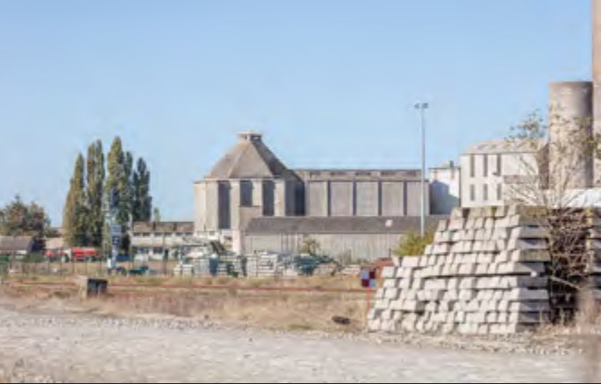
Bâtiment des fours © LMDP / Xavier Spertini, 2022
