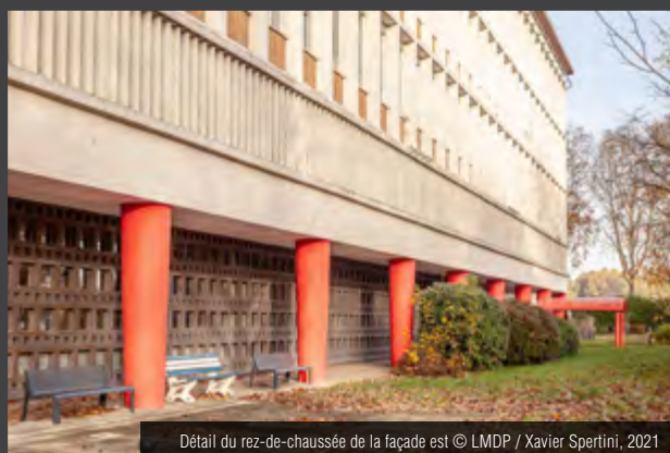
Détail du rez-de-chaussée de la façade est © LMDP / Xavier Spertini, 2021
