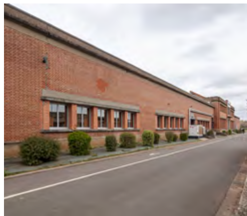
Vue arrière du bâtiment © LMDP / Xavier Spertini, 2022
