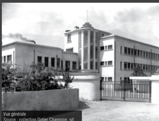
Vue de la façade principale de l'usine © LMDP
