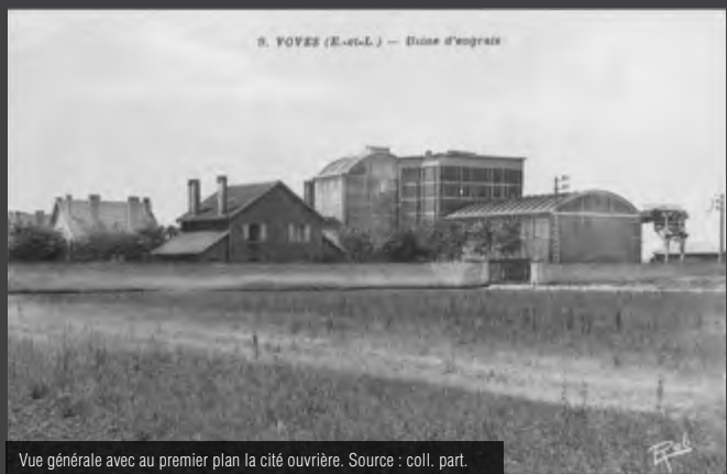
Vue générale avec au premier plan la cité ouvrière. Source : coll. part.
