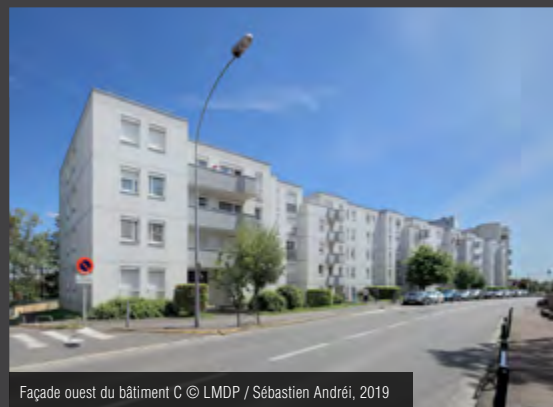
Façade ouest du bâtiment C © LMDP / Sébastien Andréi, 2019
