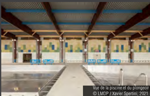
Vue des façades nord et ouest du centre nautique de Châteaudun © LMDP / Xavier Spertini, 2021
