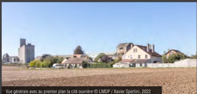
Vue générale avec au premier plan la cité ouvrière © LMDP / Xavier Spertini, 2022
