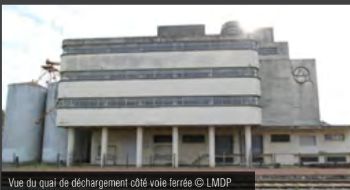
Vue du quai de déchargement côté voie ferrée © LMDP
