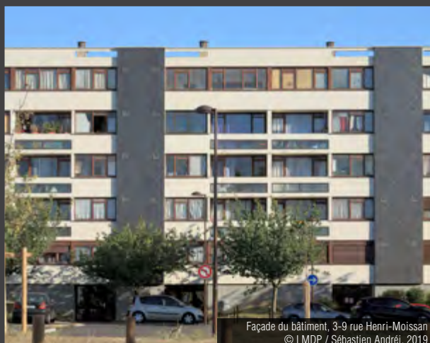
Vue d'ensemble du bâtiment, 3-9 rue Henri-Moissan © LMDP / Sébastien Andréi, 2019
