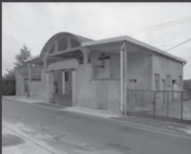
Façade et accès latéral de l'ancien abattoir avant sa réaffectation, 2000 © Robert Malnoury, Région Centre-Val de Loire - Inventaire général
