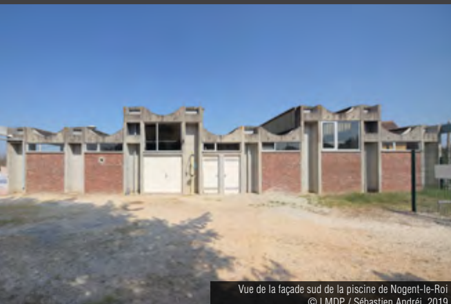
Vue d'ensemble de la piscine de Nogent-le-Roi depuis les bassins extérieurs © LMDP / Sébastien Andréi, 2019
