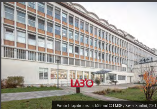
Vue de l'angle nord-est du bâtiment © LMDP / Xavier Spertini, 2021
