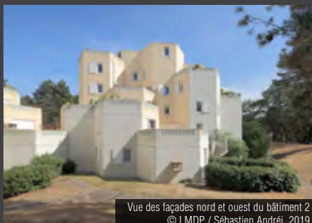
Vue de détail des façades d'un bâtiment © LMDP / Sébastien Andréi, 2019
