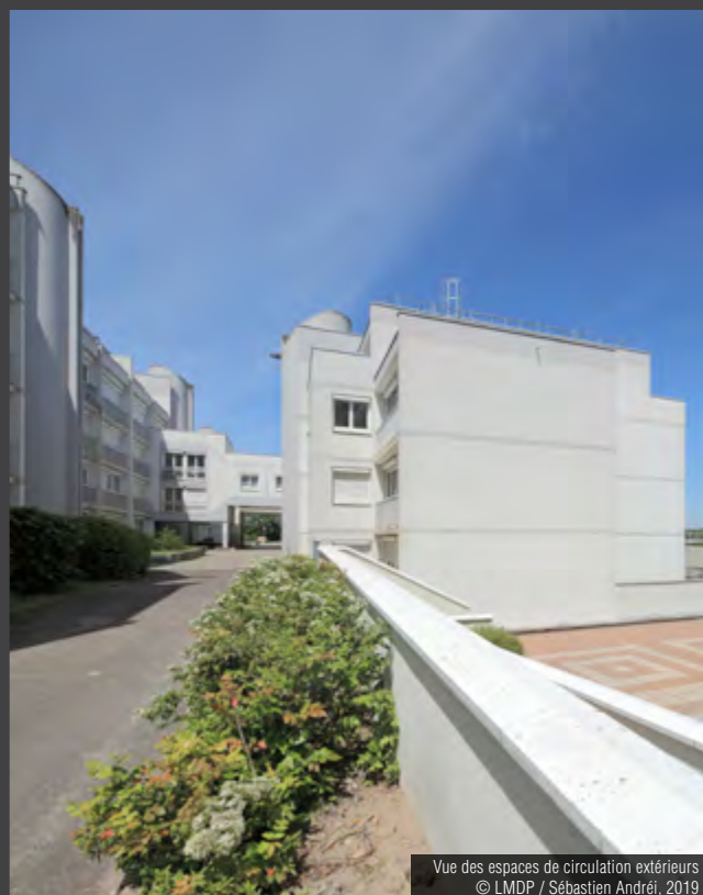
Vue d'ensemble des bâtiments A, B et D © LMDP / Sébastien Andréi, 2019
