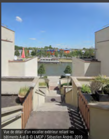
Vue de détail d'un escalier extérieur reliant les bâtiments A et B © LMDP / Sébastien Andréi, 2019
