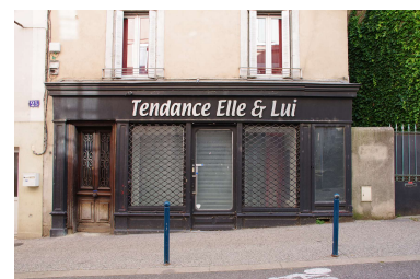
Grilles ajourées - mécanisme dissimulé dans le bandeau (Annonay)
