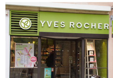
Grille de ventilation dissimulée dans le bandeau de la devanture (Aubenas)
