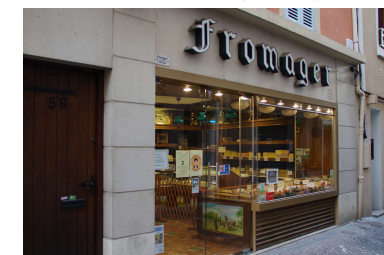
Grille de ventilation dissimulée en soubassement (Tournon s/ Rhône)
