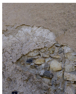
Composition d'un enduit à la chaux en 3 couches
