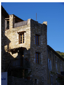
Toit terrasse (St Montan)
