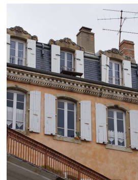
Exemple de toit « à la Mansart » (Aubenas)
