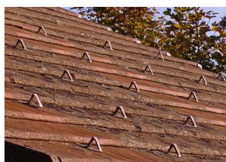
/// Tuiles mécaniques plates
