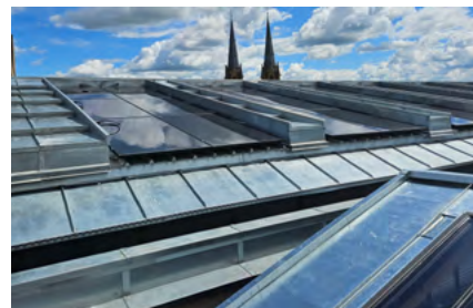
Panneaux gris, intégrés sur pan en zinc Metz (57)
