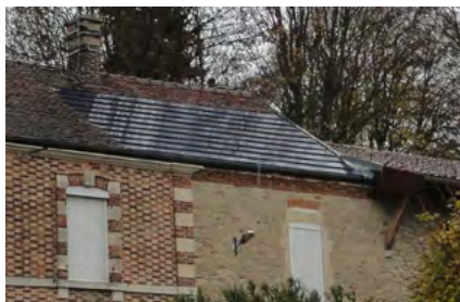
Tuiles photovoltaïques (10)
