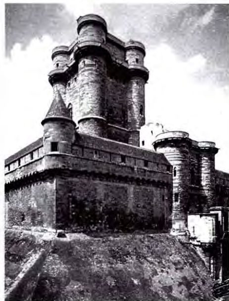
Fig. 2 : Château de Vincennes, le donjon. Photographie : Zehri et Leprince, Caisse nationale des monuments historiques et des sites / SPADEM.
